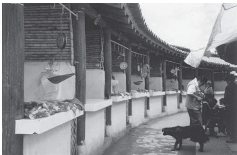
Zona de expendio de carnes – nueva infraestructura
